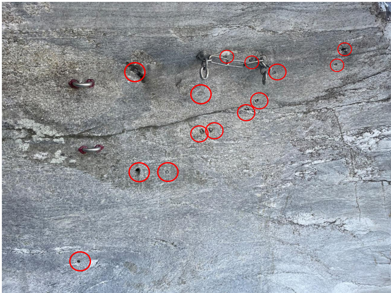
Boggera inferiore, C22 (oberhalb Blocksprung): 4 Anker und 14 Ruinen
