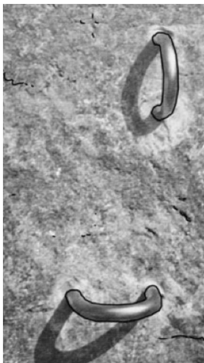
Abseilstelle vor HW recht gut geschützt.
